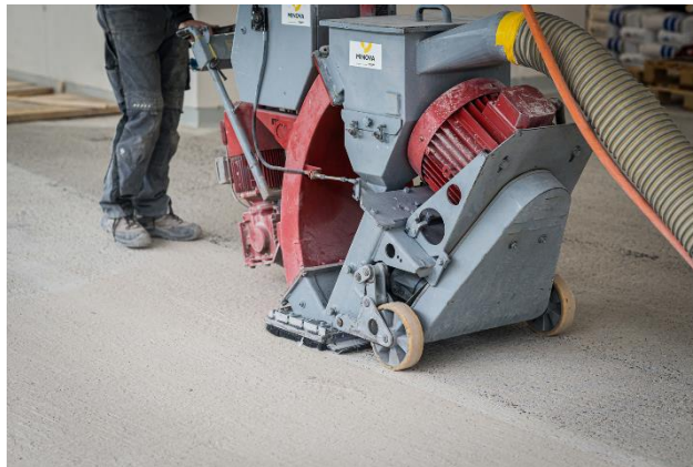
Travaux de grenailage à l'intérieur.
