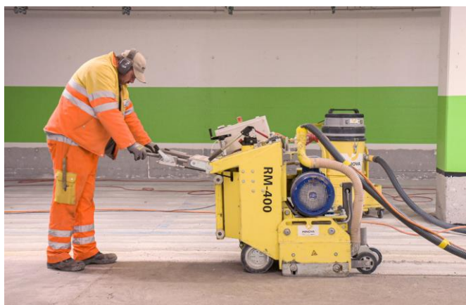
Travaux de fraisage à l'intérieur.
