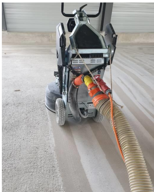
Réduction de la profondeur de rugosité du béton non taloché.
