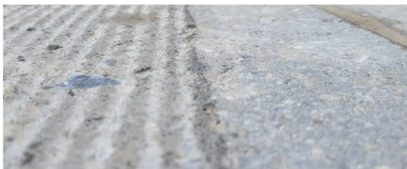
A gauche : béton fraisé / à droite : réduction de la profondeur de rugosité . Réduction de la profondeur de rugosité sur le béton fraisé. La profondeur de rugosité est réduite d'environ 4,9 mm à < 1 mm par ponçage.
