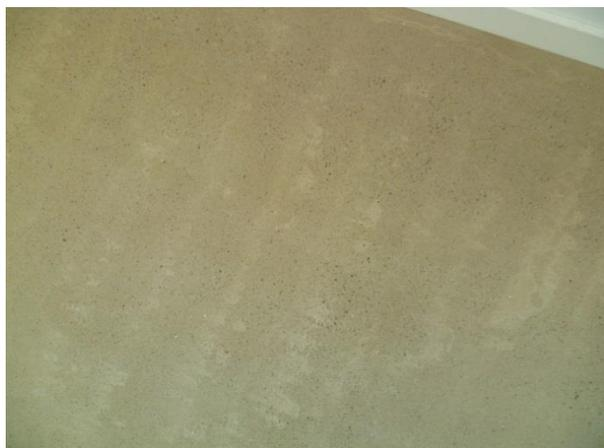
Questo pavimento non è stato levigato abbastanza intensamente e, se questo tipo di levigazione non era stato concordato, non va accettato.
