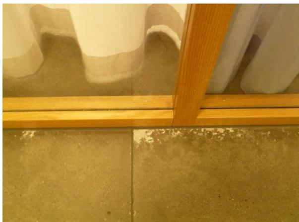
Umidità di risalita proveniente dal giunto di un massetto flottante non completamente maturo per la posa.
