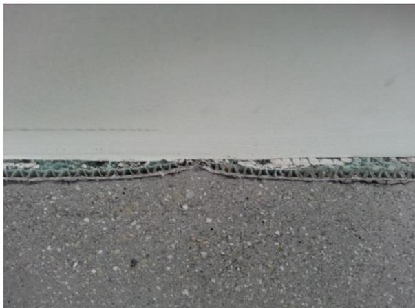
Disastroso. Banda isolante perimetrale fissata con punti metallici. Ciò crea delle fessure. (vedi raccomandazione PAV-E 20 «Banda isolante perimetrale per massetti»).
