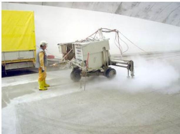
*In questo caso si è dovuto quindi ricorrere ad un'attrezzatura più abrasiva: sabbiatura ad acqua ad alta pressione a 2000 bar, con rimozione di 2-3 mm di superficie.*
