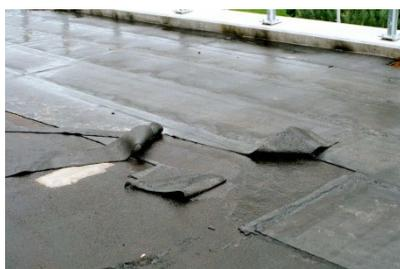
*Figura 1: Impermeabilizzazione BPP con bassissima adesione. Subito dopo la posa a fiamma l'adesione era buona, ma il giorno dopo si è rivelata del tutto insufficiente.*
