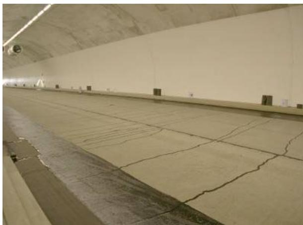
*Dopo la rimozione dello strato non solido, è emerso questo quadro con diverse fessure. Le fessure sono state riparate con bitume elastomerico.*
